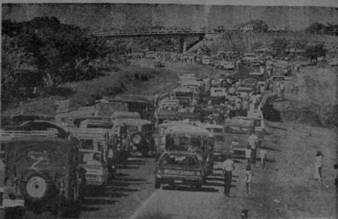
NUMEROSA ASISTENCIA. — Una gran cantidad de personas entre motorizados y peatones asistieron hoy por la mañana a los actos de inauguración de la nueva carretera Bernardo Soto que comunica El Coco con la ciudad de San Ramón. En la foto se aprecia la intersección con la carretera a Ciruelas. (Foto Córdoba).
